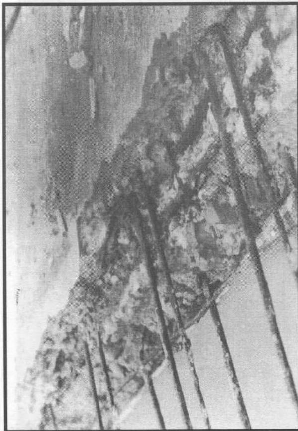
**FOTO 12.6.- REFUERZO TOTALMENTE CORROIDO EN ALIGERADO (Mollendo-Arequipa)**
