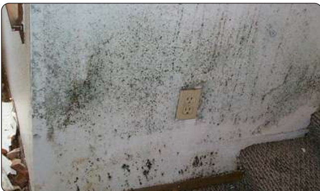
Foto N° 1 Aspergillus en muro (Fuente : Test America Environmental Microbiology Laboratory Inc.)
