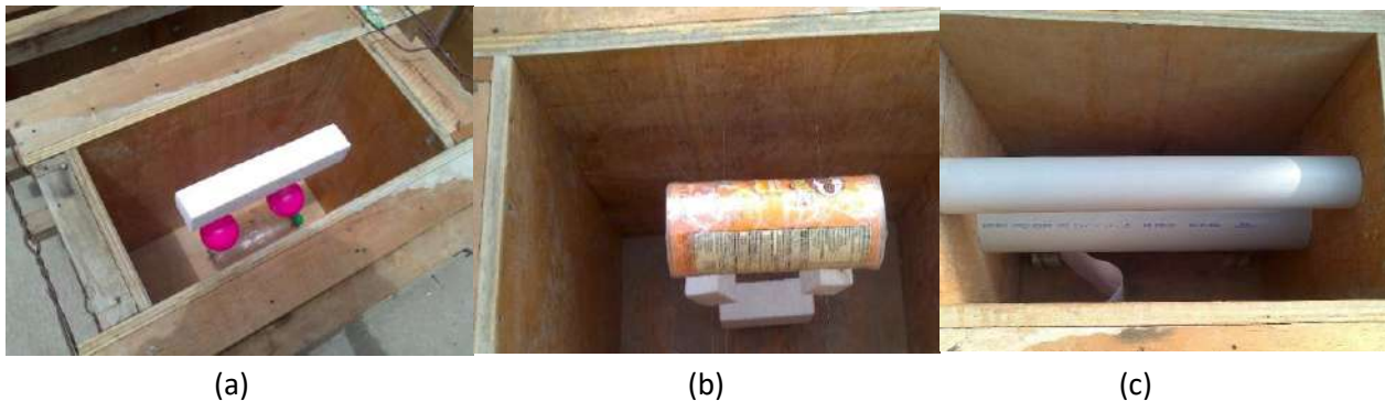
Figura 7. Encofrados de los muros (a) modelo 1 (b) modelo 2 (c) modelo 3
