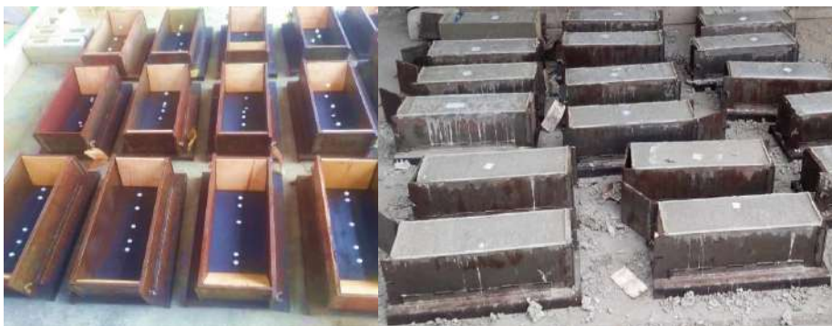
Figura 6. Elaboración de las vigas (a) Encofrados (b) Vigas de concreto
